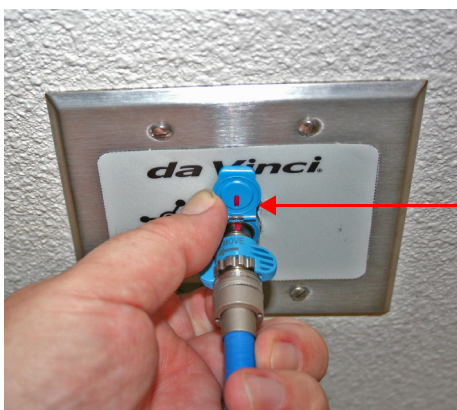
Figura D.6 Ligar a outra extremidade do cabo de fibra à placa de parede de fibra
